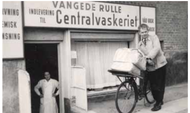
'Rullefar' ved cyklen på vej ud for at aflevere rent tøj mens 'rulleemor' står i døren. Den lille kælderbutik har gennem tiderne lagt hus til mange forskellige butikker, som f.eks. tøj, børnetøj og havemøbler. Den har desværre nu været lukket med brunt papir for vinduerne i nogle år, men vi håber stadig at der kommer gang i den lille hyggelige butik. Foto privateje.
