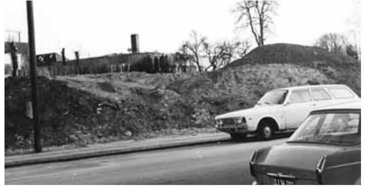
Billedet er fra 1976 og viser byggetomten efter den gamle kirke er revet ned og her skal der så bygges Vangedes nye bibliotek. Biblioteket havde hidtil ligget i en lejlighed i Vangede Bygade 39 på første sal over der hvor Floristen og Thomsen Cykler ligger nu. Bemærk man kan lige ane Villabyernes Bio i baggrunden. Foto Lokalhistorisk Arkiv i Gentofte
