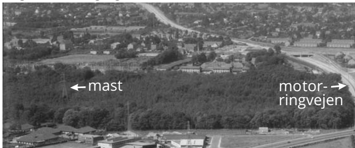
1956. Motorringvejen til højre i billedet og Mesterloddan nederst. Højspændingsmasten ses til venstre i mosen.
