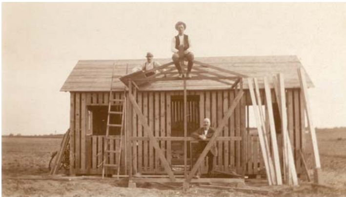
Huset under opførelse i 1923. I baggrunden til venstre for huset kan man ane Søborg Kirke (bygget i 1914)
