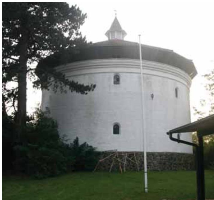
Ræveskovsvandtårnet med spejderhytte for Charlottenlund gruppe i forgrunden til højre. Fra denne vinkel ses hele bygningskroppen, udsigtsplatformen og det 16-kantede tag kronet af den 8-kantede kobbertægte tagrytter og spiret med vindfløj.
