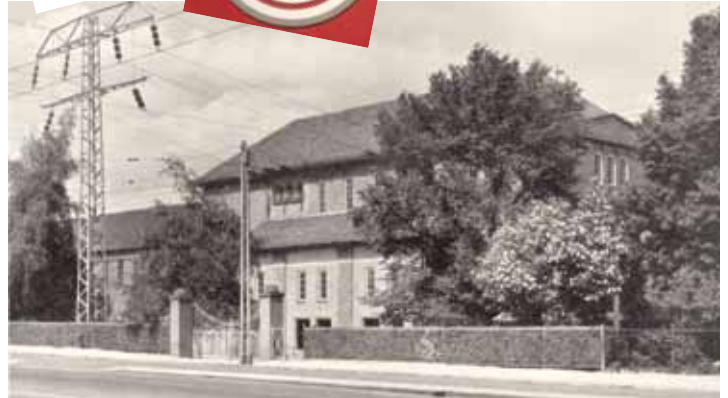
Ørnegård transformatorstation, der er opført 1918, var en statelig bygning i en borgagtig arkitektur. Bygningen lå ud til Lyngbyvej, herfra ledede NESA det fælles ledningssystem, der sikrede strøm til Nordsjælland. Nordsjællands Elektricitets og Sporvejs Aktieselskab 1902-52.
