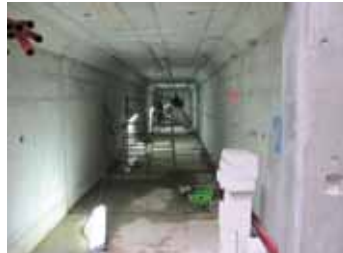
Et kik ind i den 56 meter lange tunnel under Lyngbyvejen fra P-plads til virksomheden DONG. Foto: NUKH
