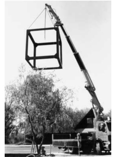
I 1996 blev von Spreckelsens egne tegninger til det karakteristiske klokketårn endelig realiseret. Her hejses en af de seks stålrammer fra Bornholm på plads.
