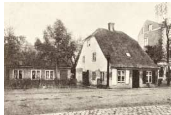
Foto af Hellerup Bomhus kort før nedrivningen i 1900. I huset til venstre boede bombetjentene, mens bommanden havde bolig i selve bomhuset. På facaden ses de to bomtavler med priser for bompassage. Fra Fem mil langs Øersund s.197
