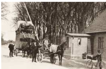
Bomhuset på Lyngbyvej ved Lundehuset passeres af et flyttelæs på dets sidste dag 31. marts 1915.
