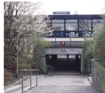
Kildebakke Station i 2008 efter sporombygningen set fra øst.
